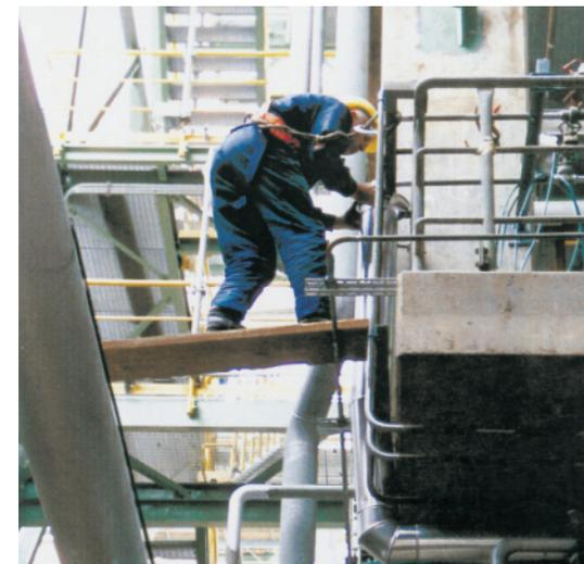
Abbildung 27: Arbeiten an einer Rohrleitung: Hier wäre das Einbinden in die vordere Auffangöse besser. Beim Einbinden hinten kommt es beim Abfangen des Sturzes zu einer gefährlichen Drehbewegung
