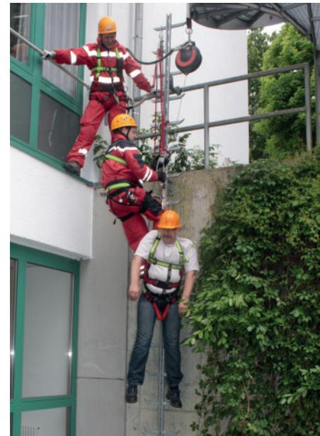
Abbildung 47: Rettung aus einer Steigschutzeinrichtung (Übung im Rahmen eines Seminars der BG RCI)
