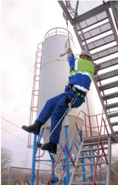
Abbildung 43: Entlastung durch eine Trittschlinge (hier durch einen Seilkürzer realisiert)
