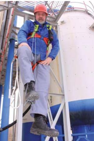
Abb. 4 Entlastung durch Stemmen eines Fußes in eine Trittschlinge
