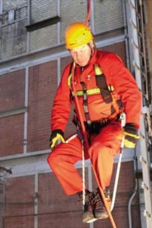
Abb. 3 Halteseil mit Längeneinstellvorrichtung
