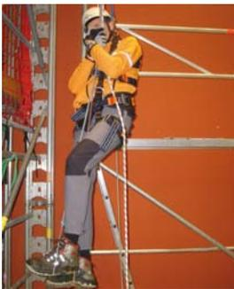
Abb. 5 Anwendung der Prusikschlinge
