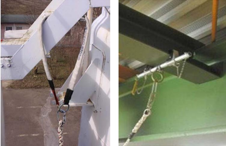
Abb. 14 Beispiele für Anschlagseinrichtungen der Klasse B – Bandschlinge, Trägerklemme
